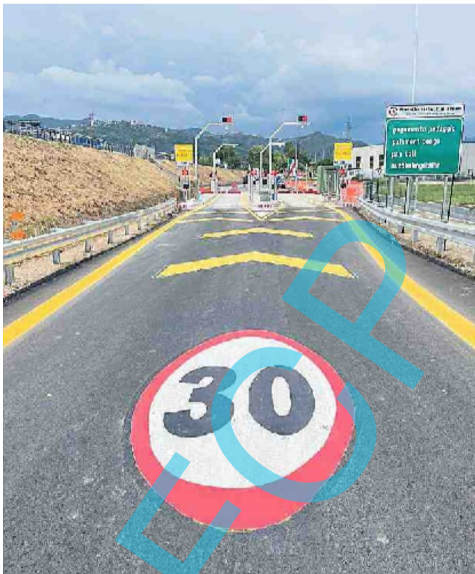
Le nuove rampe sull'A12
